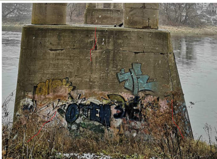
21 pav. Vertikalūs plyšiai atramos Nr. 2 apatinėje dalyje,
