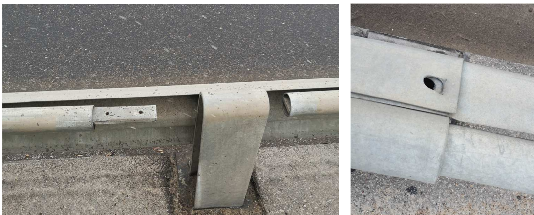
5 pav. Trūksta metalinių jungiančiųjų elementų atitvaruose
