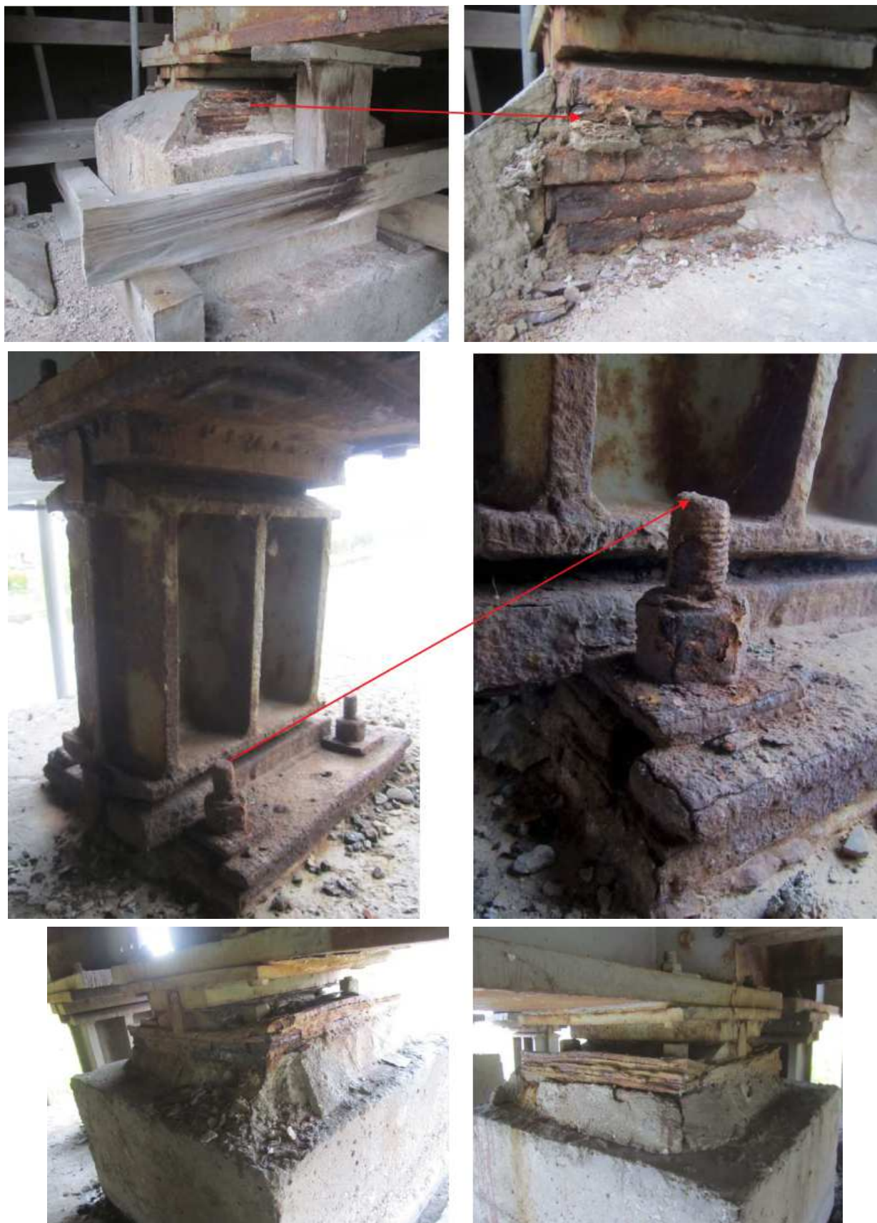
15 pav. Atraminiai guoliai paveikti korozijos
