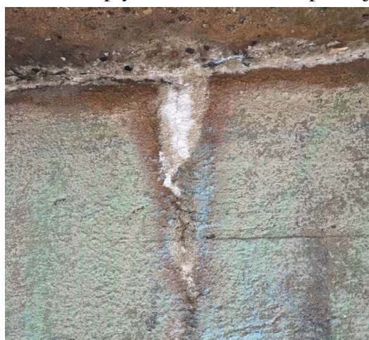
22 pav. Iš plyšių atramoje Nr. 2 matosi plaunami karbonatai
