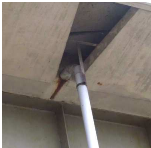
12 pav. Nesandarios PVC vamzdžių jungtys su metaliniu vamzdžiu, matosi prabėgančio vandens žymės
