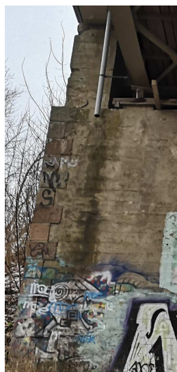
18 pav. Netvarkingas lietaus vandens nuvedimas, lietaus vanduo bėga tiesiai ant ramtų
