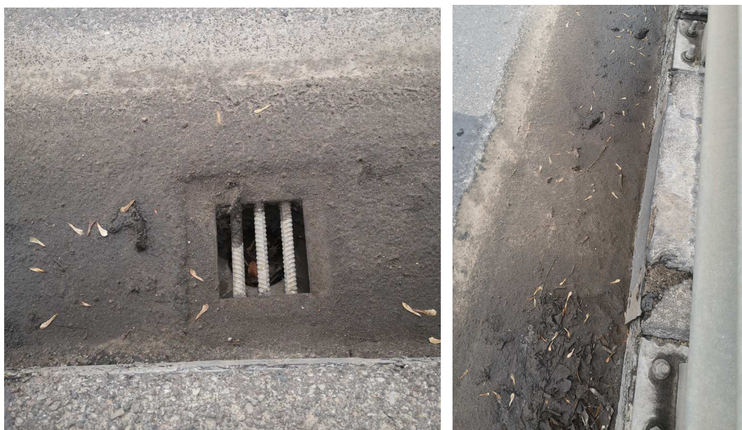
11 pav. Ties lietaus vandens nuvedimo šulinėliais kaupiasi purvas, nešvarumai, nėra efektyviai nuvedamas lietaus vanduo
