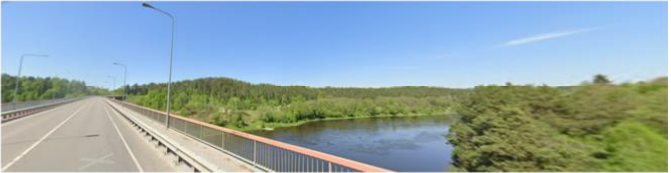
10 pav. Vaizdas nuo Tūkstantmečio tilto PS-5 funkcinės zonos kryptimi (duomenų šaltinis: Google žemėlapiai)
