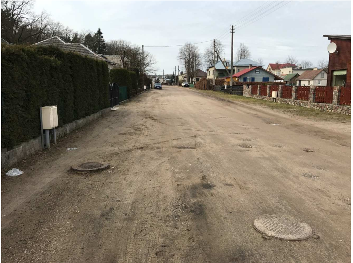
5 pav. Rekonstruojama Vidzgirio gatvė
