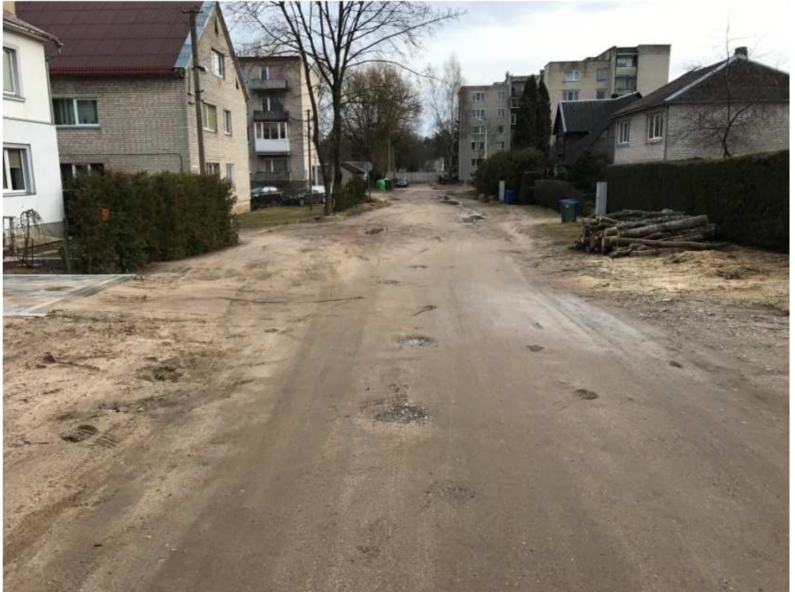
4 pav. Rekonstruojama Miško gatvė
