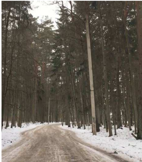
Pav. 3 Esama elektros atrama šalia projektuojamo kelio
