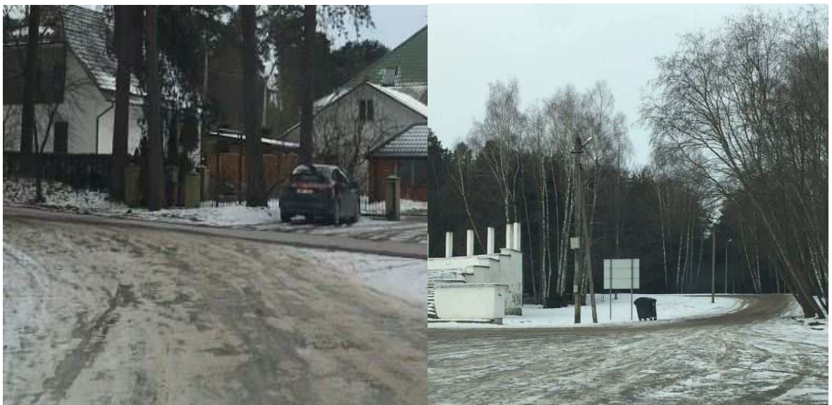
Pav. 2 Esama privažiavimo kelio važiuojamosios dalis ties trasos pradžia (kairėje) ir trasos pabaiga (dešinėje)
