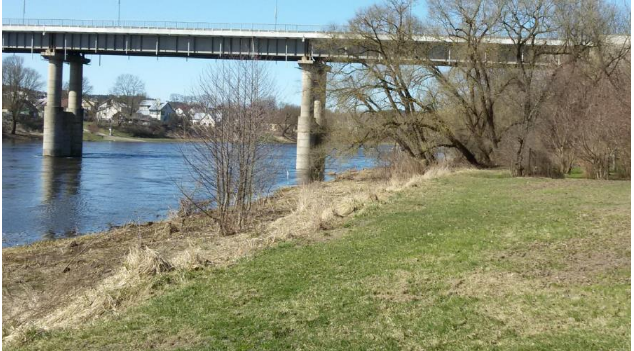
2.7 pav. II ETAPO trasa po A. Juozapavičiaus gatvės tiltu
