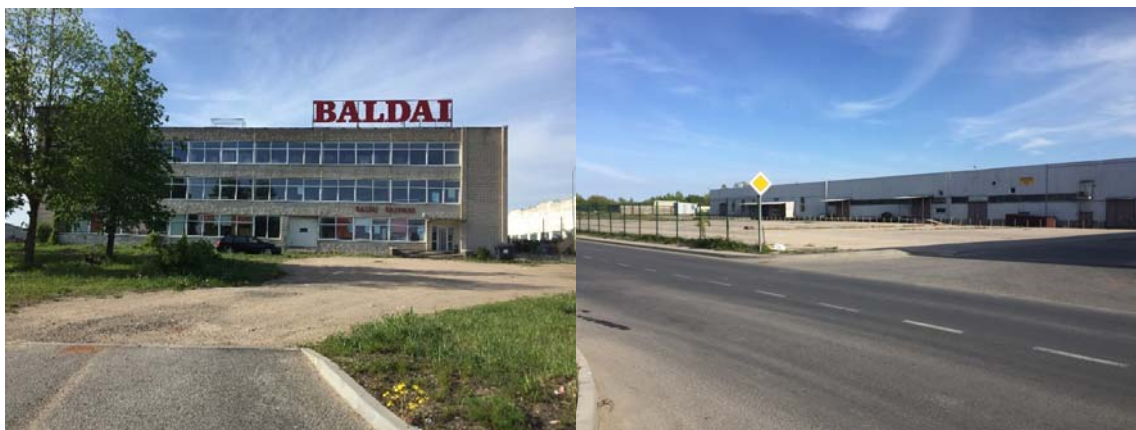
5 pav. Esami pastatai planuojamoje teritorijoje
