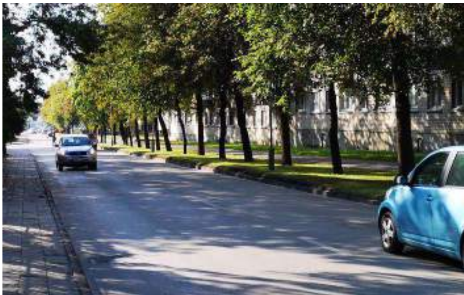
2,3. pav. Esama gatvės dangos būklė
